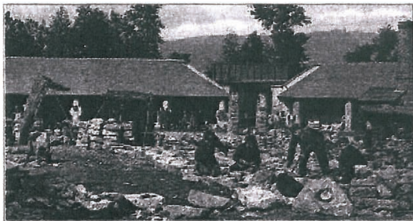
Taille des meules sur le chantier de la Ferté-sous-Jouarre, capitale de la fabrication.
